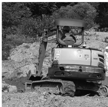
被災現場で作業する重機
